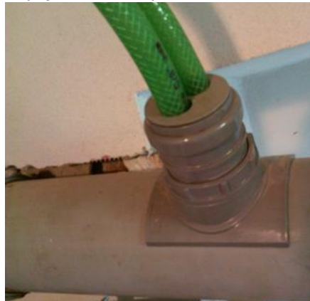
Zapojení dvou odpadů do kanalizace
