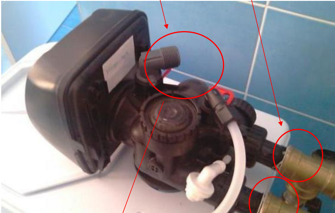
Zapojení dvou odpadů do kanalizace
